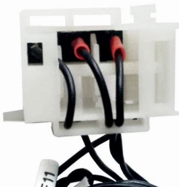
El contacto auxiliar nos permitirá conocer la indicación del estado de los contactos del interruptor.
